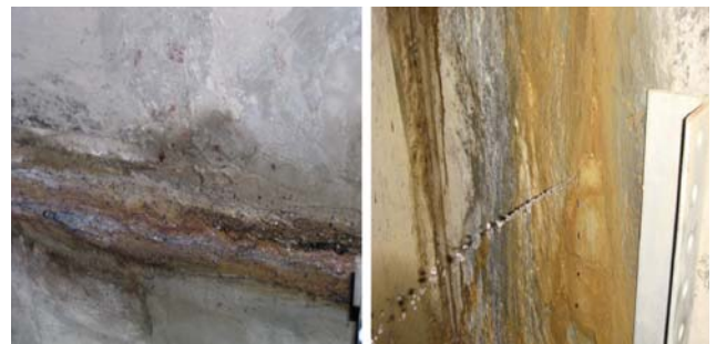
圖 8 伸縮縫漏水造成隧道積水
