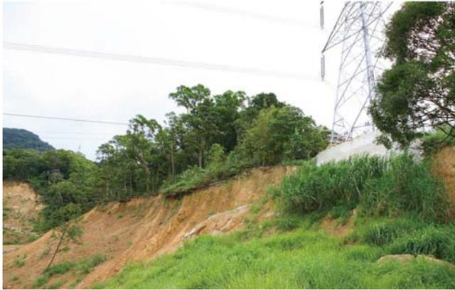
圖 7 台電 345KV 高壓電塔邊坡滑動情形
