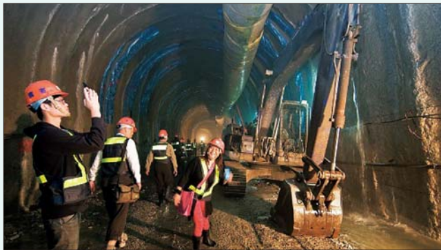
既有廠房之通道
