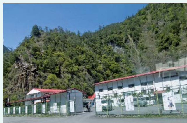
台電青山施工處辦公室
