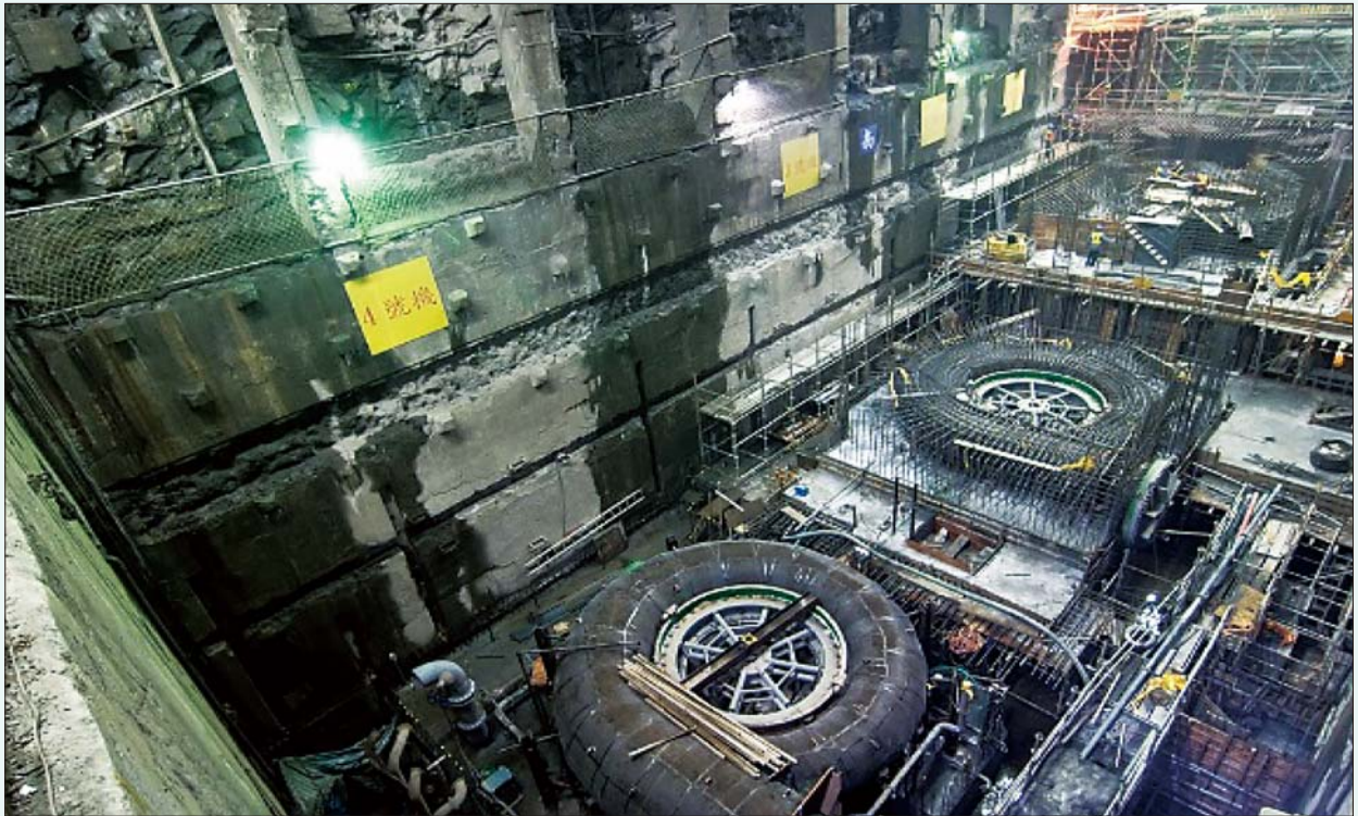
施工中的青山4部機現況
