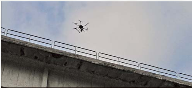
圖 14 近距離結構安全檢查
