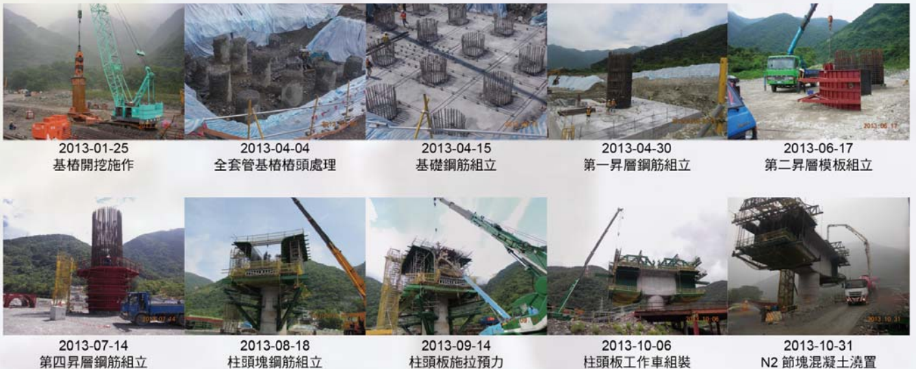
圖 15 蘇花改 A3 標東澳北溪河川橋 P2S 橋墩施工過程照片集合例
