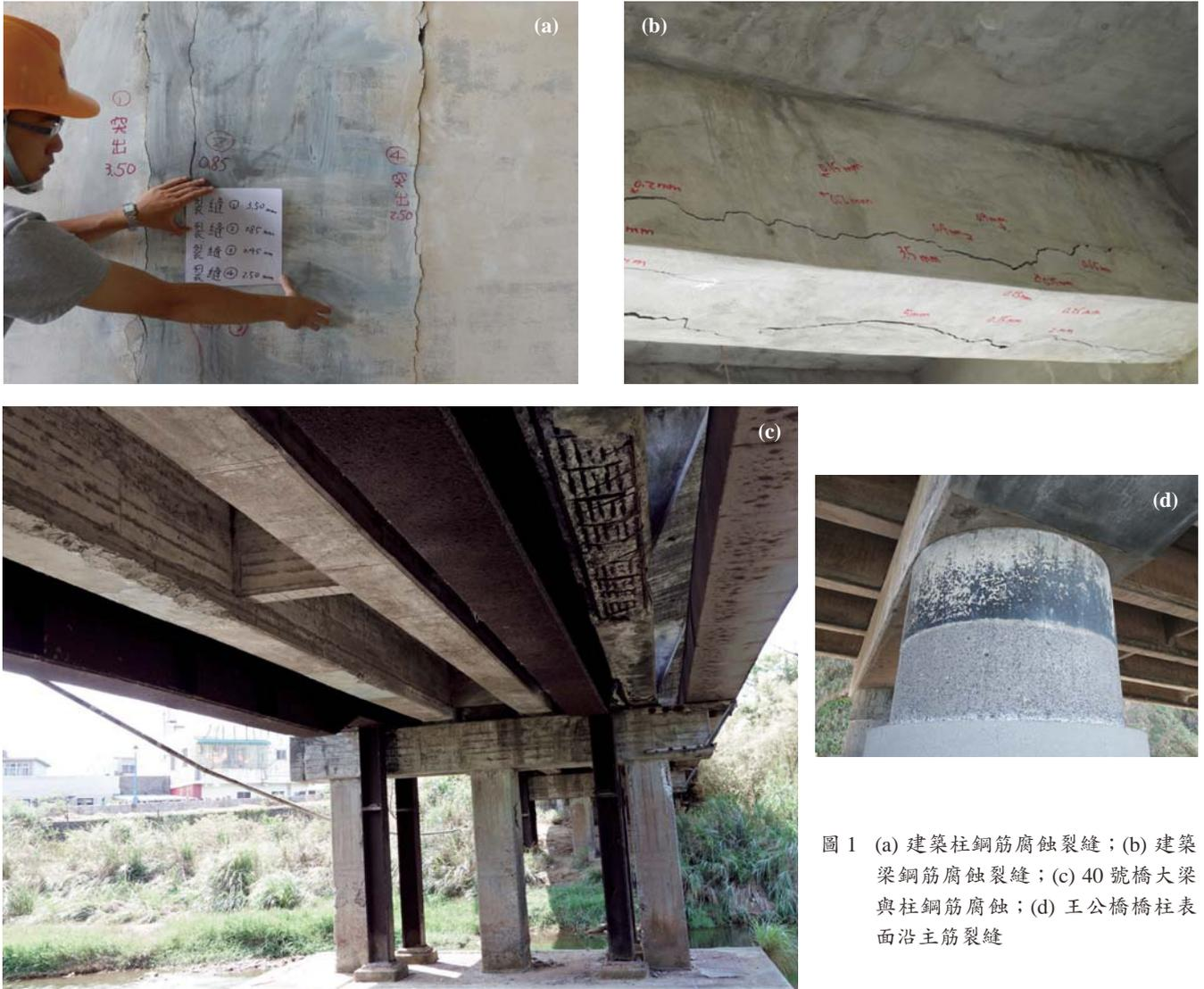
圖 1 (a) 建築柱鋼筋腐蝕裂縫；(b) 建築梁鋼筋腐蝕裂縫；(c) 40 號橋大梁與柱鋼筋腐蝕；(d) 王公橋橋柱表面沿主筋裂縫
