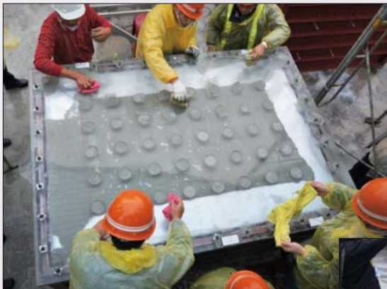
(b) 第 1 次灌漿照片(下層隔板)
