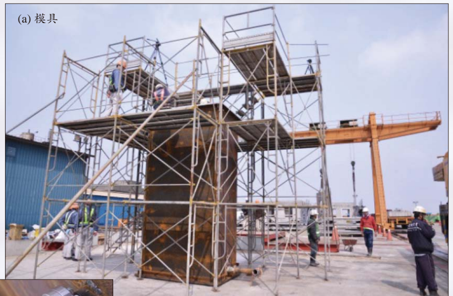
圖 10 第三階段灌漿模具之製造
