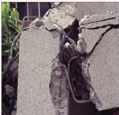
圖 17 梁筋錨定不足破壞
