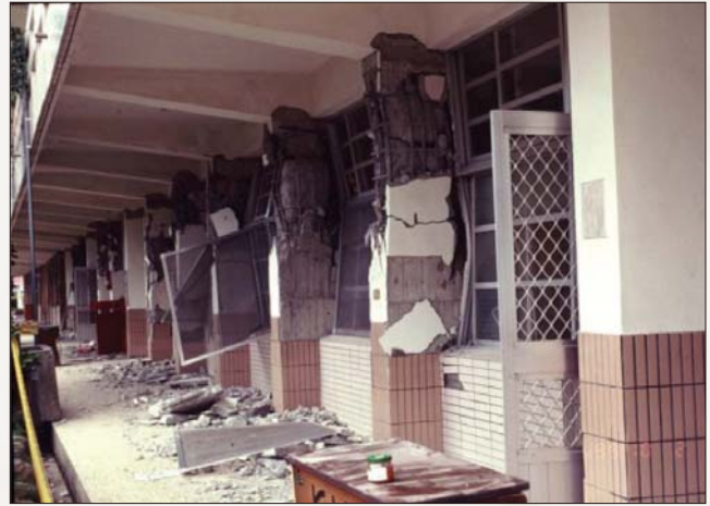
圖 7 短柱效應的破壞例
