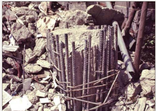
圖 4 柱筋搭接破壞案例
