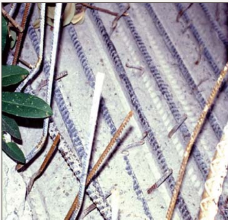
圖 16 繫筋 90°彎鉤拉開破壞
