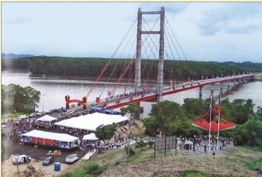
92.3 榮工公司在中南美哥斯大黎加完成的斜張橋—台灣友誼大橋完工通車
