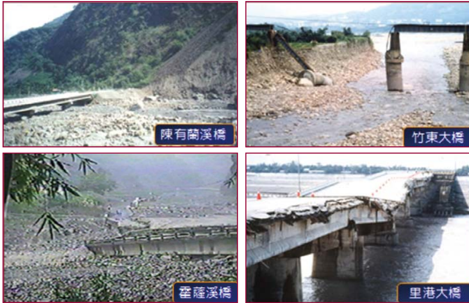
圖 8 1996 年賀伯颱風 — 橋梁水害及土石流災害 [19]
