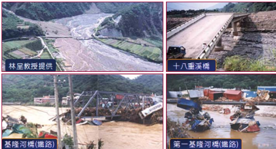
圖 9 2001 年桃芝颱風 — 橋梁土石流災害 (上) [20] 2001 年納莉颱風 — 橋梁水害 (下)
