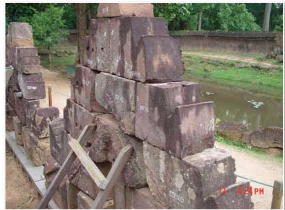
圖 28 女皇宮 (Banteay Srei) 曾經被盜、被毀，岩塊散落各地，編號以電腦媒合重組 (黃重遠攝)
