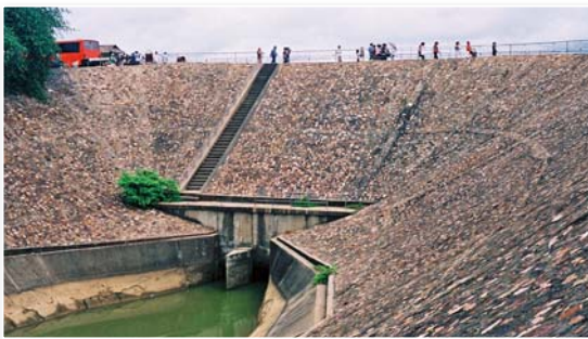
圖 9 吳哥西大湖 (West Baray) 出水口下游及灌溉渠道渠首段近照 (洪如江攝)
