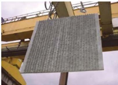
圖 25 Viaduc du Cher 橋柱之高性能纖維混凝土補強包覆版 [33,34]
