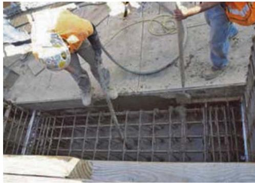
(d) 高性能纖維混凝土連接梁灌漿
