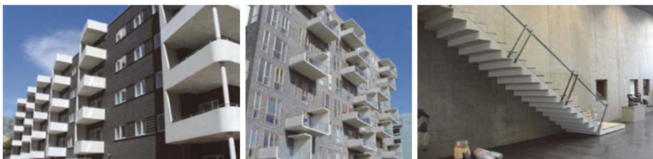
(a) 超高性能纖維混凝土陽台與柱      (b) 超高性能纖維混凝土陽台      (c) 超高性能纖維混凝土樓梯 (牆未支撐樓梯)
