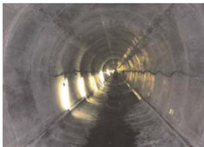
圖 26 日本細川地下渠道以超高性能纖維混凝土修復完成照 [50]
