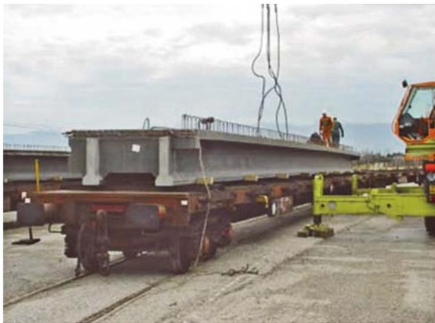
圖 12 法國 Bourg-lès-Valence 橋梁採用之超高性能纖維混凝土橋面板
