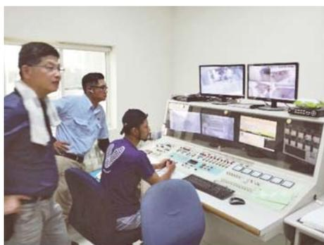
(a) 預拌廠內以電腦控制拌合流程
