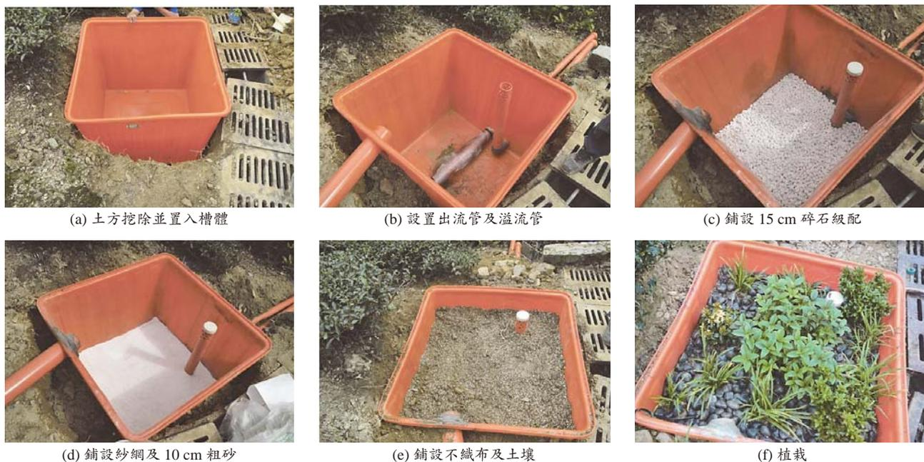
圖 6 植生滯留槽施工步驟
