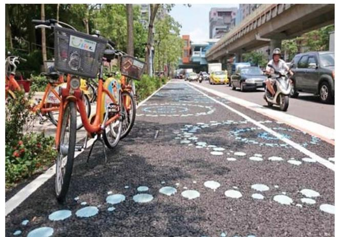
圖 6 復興南路自行車道多孔隙混凝土
