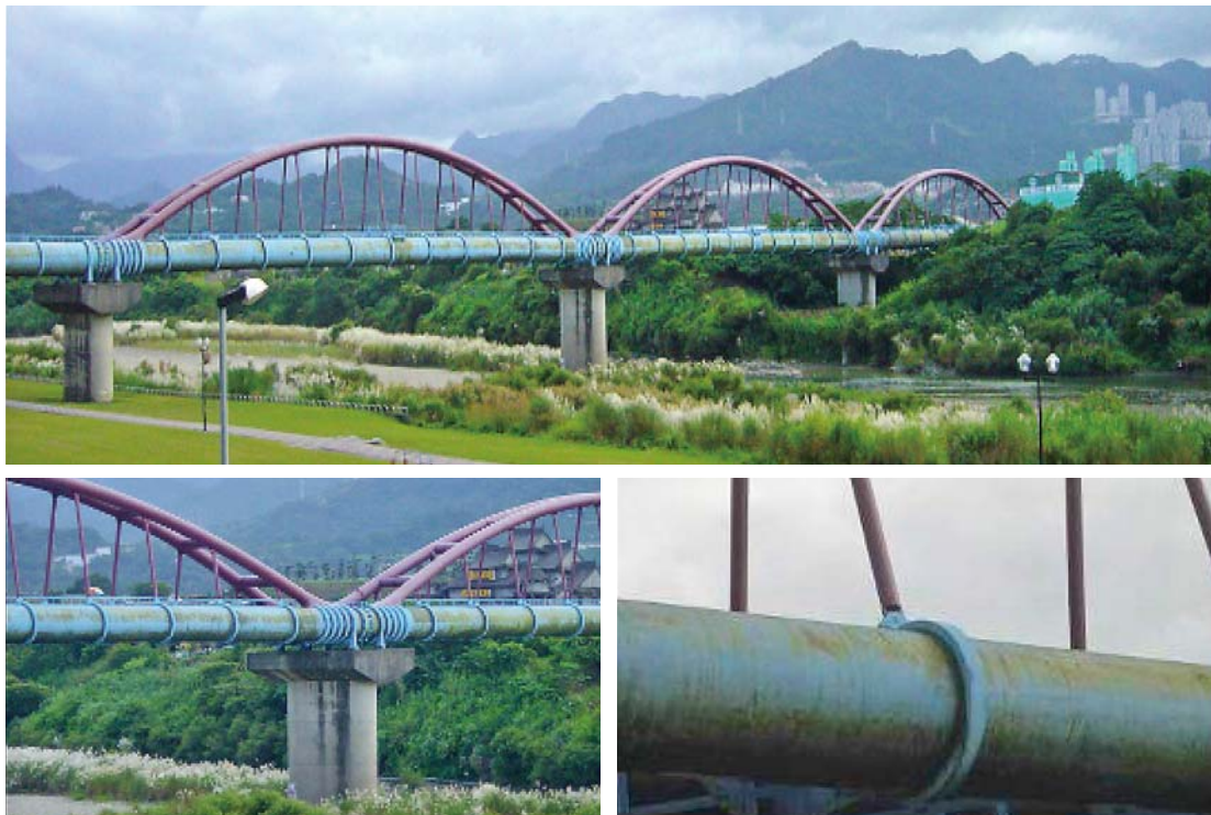
圖 1 水管橋構造
