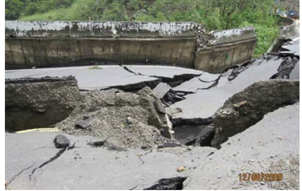
圖 1 道路位於滑動區而破壞
