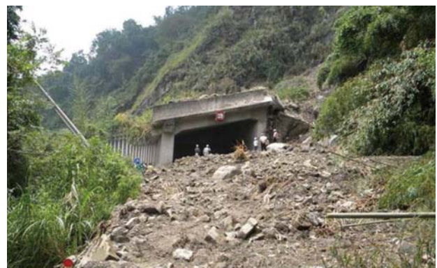
圖 12 明隧道長度不足洞口遭土石掩埋
