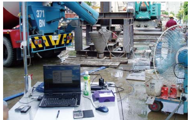
圖 6 逆打鋼柱偏移量採自動計讀
