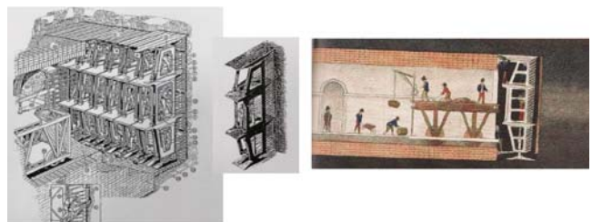
圖 3 Brunel 矩形潛盾與鑽掘施工
