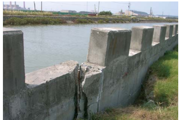
圖 2 河岸設施因被動不足而位移
