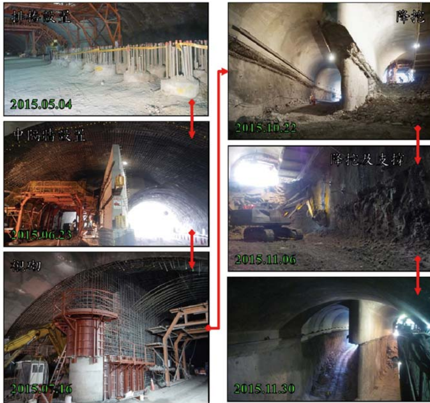
圖 12 消能池 1k + 008.12 中間柱區域施工流程圖
