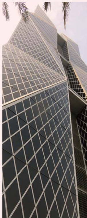
引用照片，摘自高雄中鋼集團總部大樓
