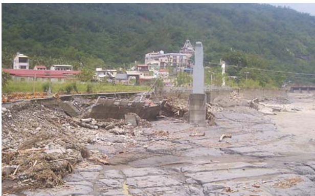
圖 10 護岸基礎掏刷而破壞
