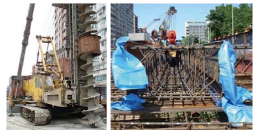
(a) 岩層引孔設備 (b) 連續壁縮小單元
