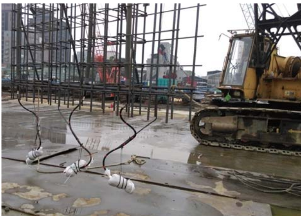
圖8 連接PVC管之單向逆止閥與高壓管
