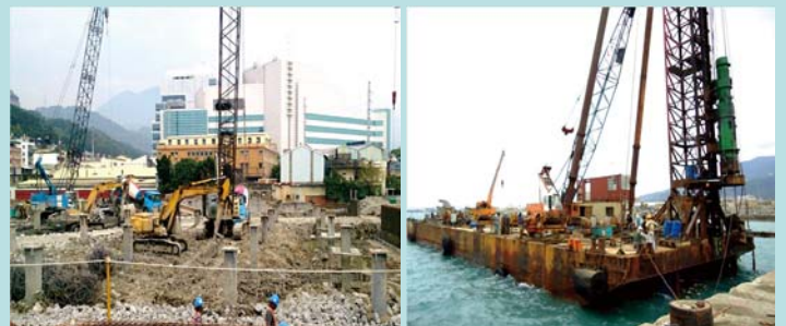
逆打鋼柱及基樁工法
