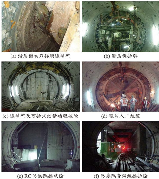
圖 16 鏡面破除施工照片
