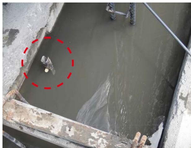
圖11 母單元外側預埋導軌
