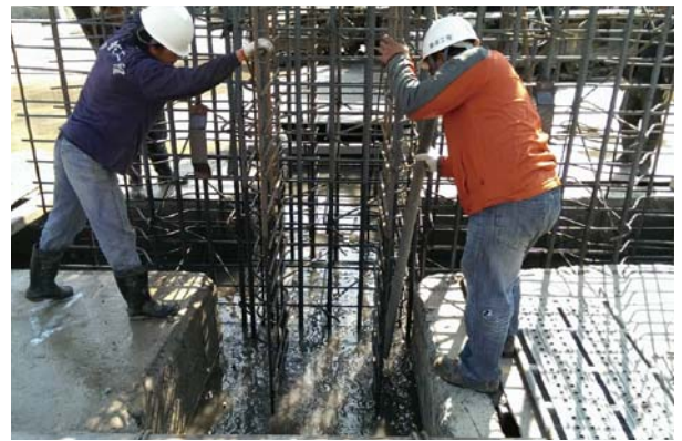
圖 5 十字型鋼筋籠
