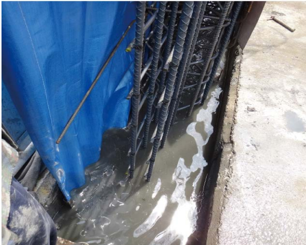
圖 12 公單元開挖面上設置帆布與導桿
