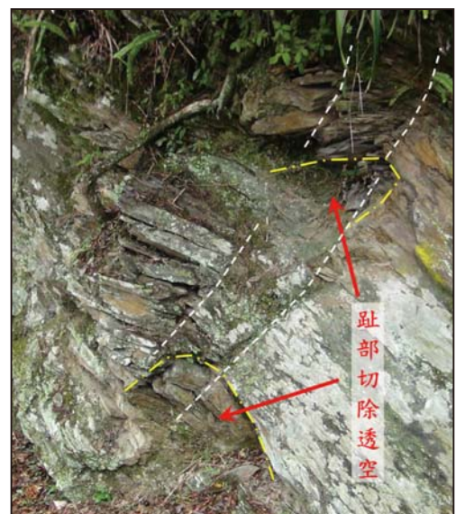
圖 9 武嶺附近板岩逆向坡趾部透空與滑動面（白色虛線）形成現況（2016 年拍攝）
