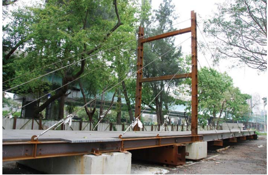
圖 5 複合材料輕量化便橋組立實體
