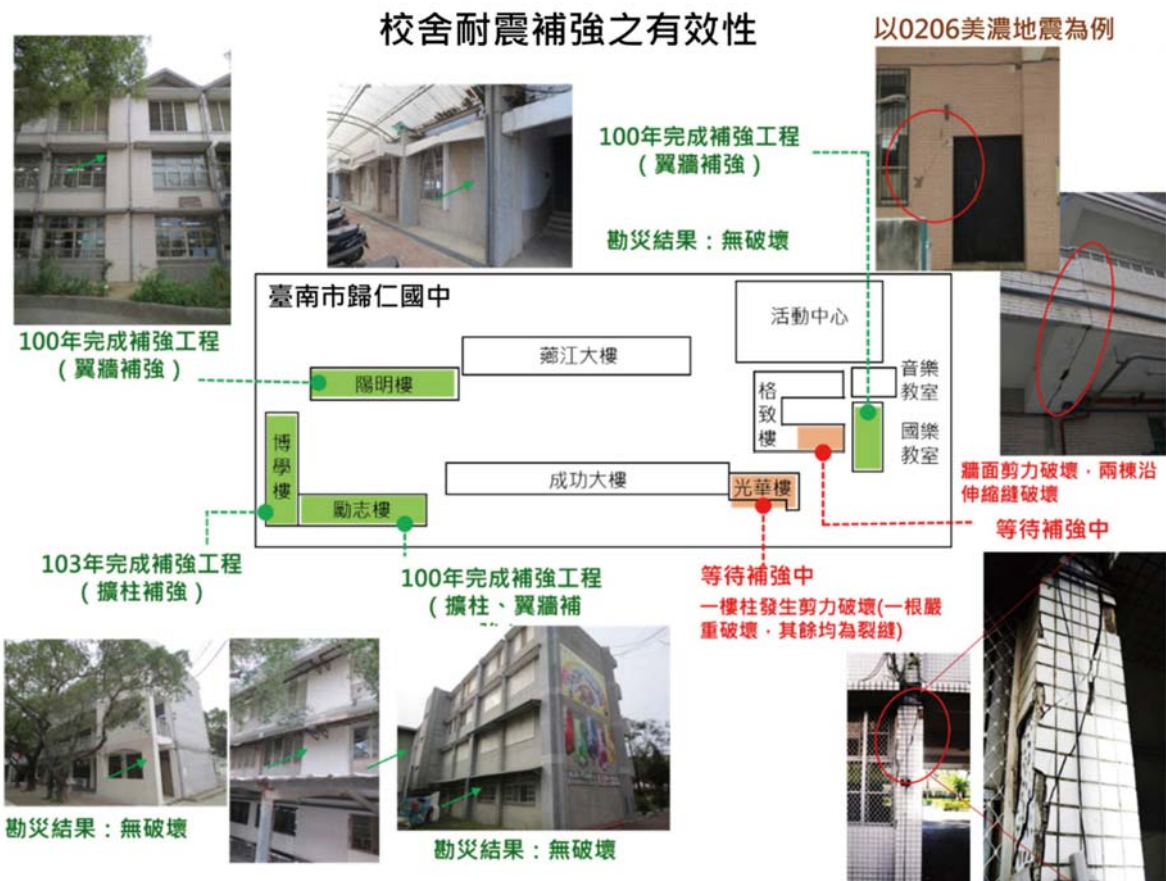
圖2 在0206美濃地震中，臺南市歸仁國中已完成補強校舍均無損壞，待補強之校舍則發生結構性破壞。
