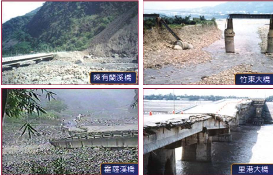
圖 8 1996 年賀伯颱風 — 橋梁水害及土石流災害<sup>[19]</sup>
