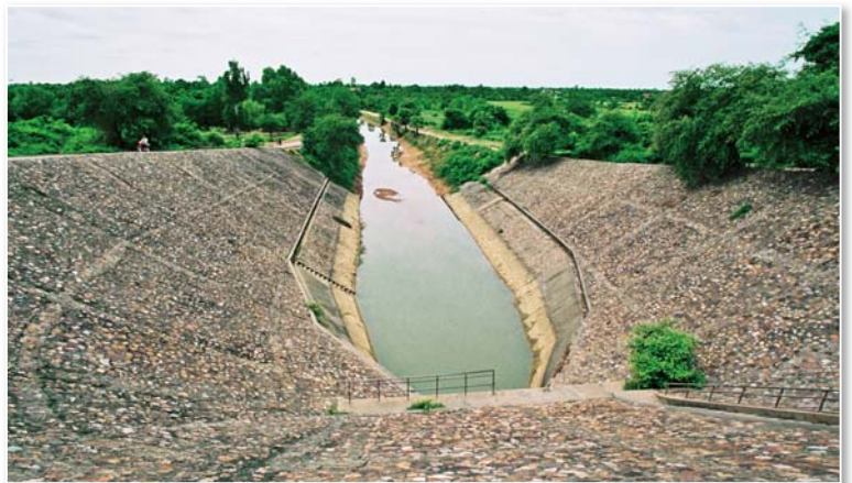
圖 10 由吳哥西大湖 (West Baray) 堤頂向下拍攝灌溉渠道首段 (洪如江攝)
