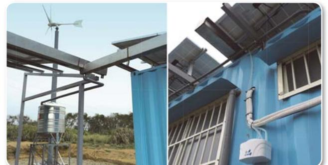
圖 4 集水天溝與蓄水塔（左）及冷氣排水回收（右）設施
