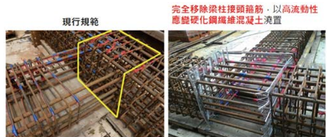
圖 8 LAMV (左) 及 LAMV_SF (右) 接頭處橫向箍筋配置比較
