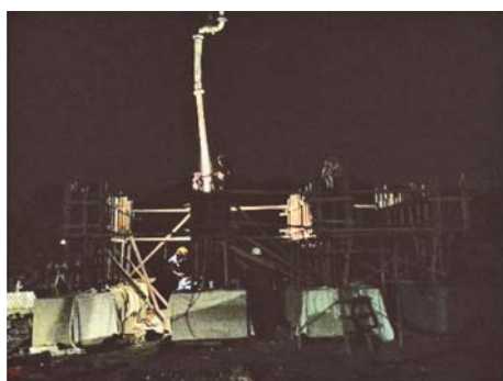
(d) 泵送車夜間澆置超高性能纖維混凝土
