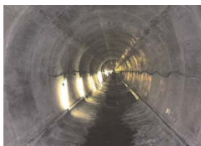
圖 26 日本細川地下渠道以超高性能纖維混凝土修復完成照 [50]
