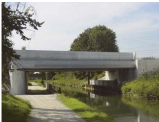
(b) 高速鐵路烏爾克運河跨越橋 [61]
