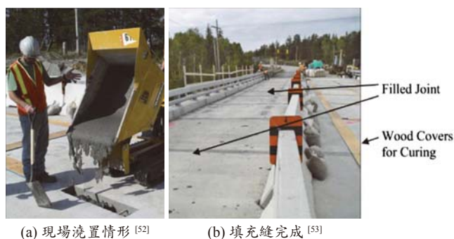
圖 28 超高性能纖維混凝土於預鑄橋面版填充縫之應用
