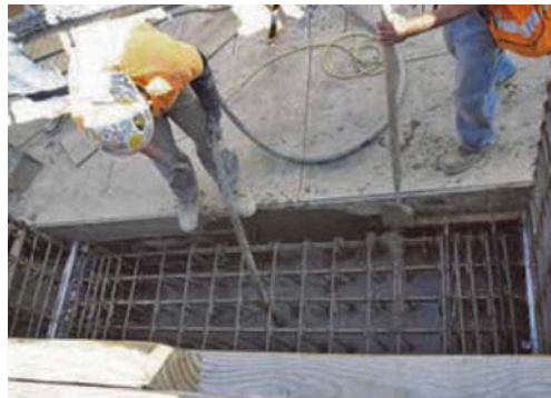
(d) 高性能纖維混凝土連接梁灌漿
