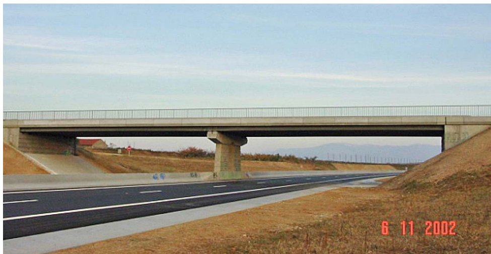
(a) 法國 Bourg-lès- Valence 橋梁 [33,34]
