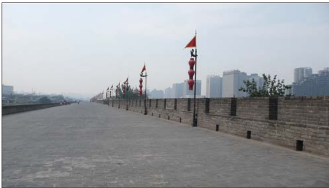
圖 10 唐朝所建長安城城牆頂面現況（林美聆攝）
