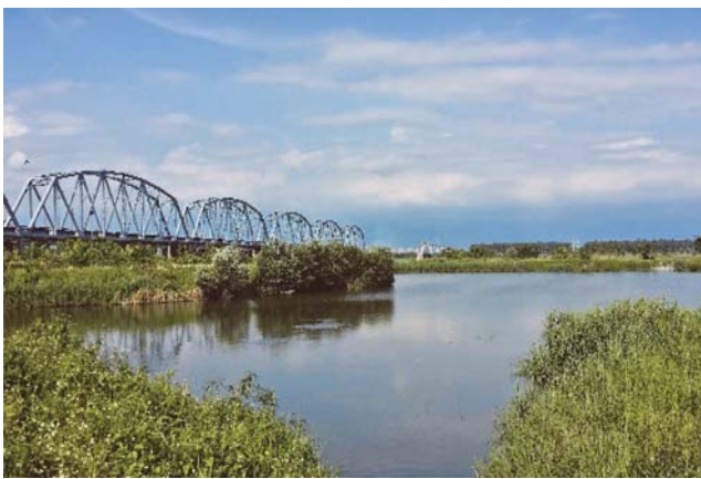
圖 2 現今大樹舊鐵橋濕地
