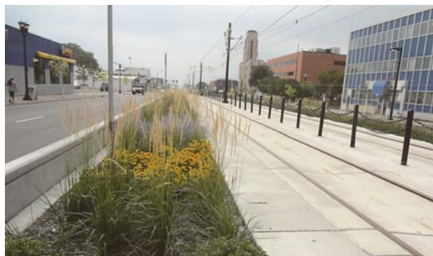
圖 4 美國明尼蘇達雙子城將雨水處理設施與大眾運輸計畫結合設計。此為其中輕軌綠色支線 (green line) 的植生滯留槽設施照片，成為名副其實的綠線 (green line)。
