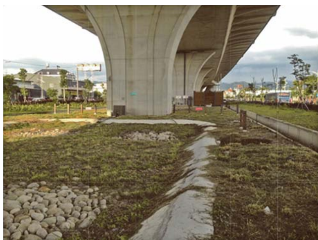
圖 8 臺中生活圈 2 號線環中路 LID 設施完工後照片
