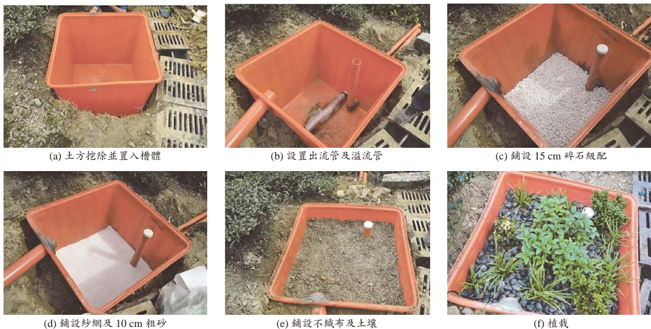
圖 6 植生滯留槽施工步驟
