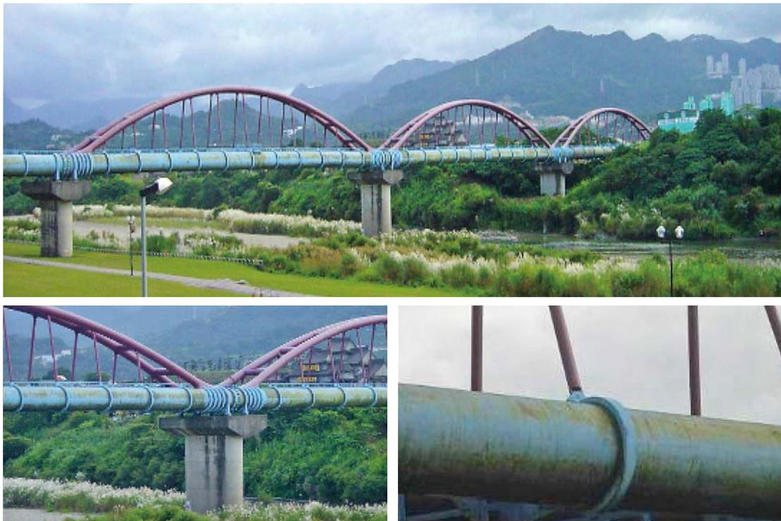
圖 1 水管橋構造
