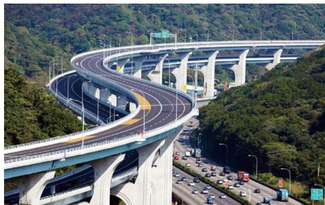
履獲國際大獎肯定的高速公路五楊段拓寬工程 承包工程的廠商卻沒有一家賺錢
