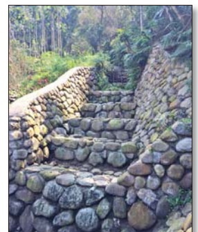
土石流生態自然工法施工成果
