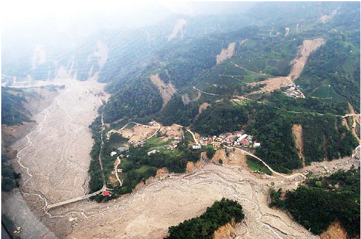
圖 7 橋梁遭洪水、土石流沖毀
