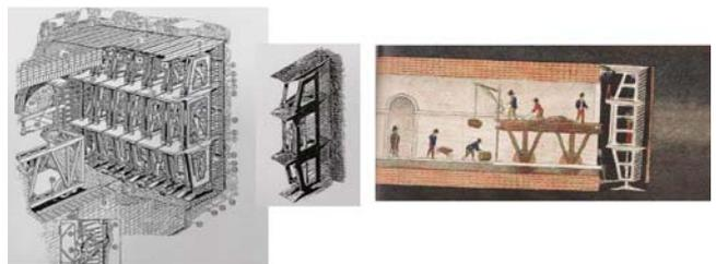
圖 3 Brunel 矩形潛盾與鑽掘施工
