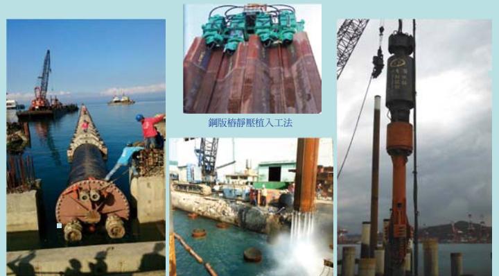
菲律賓電廠HDPE進水管工程
