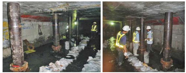
圖 13 箱涵圍堰導水示意圖
