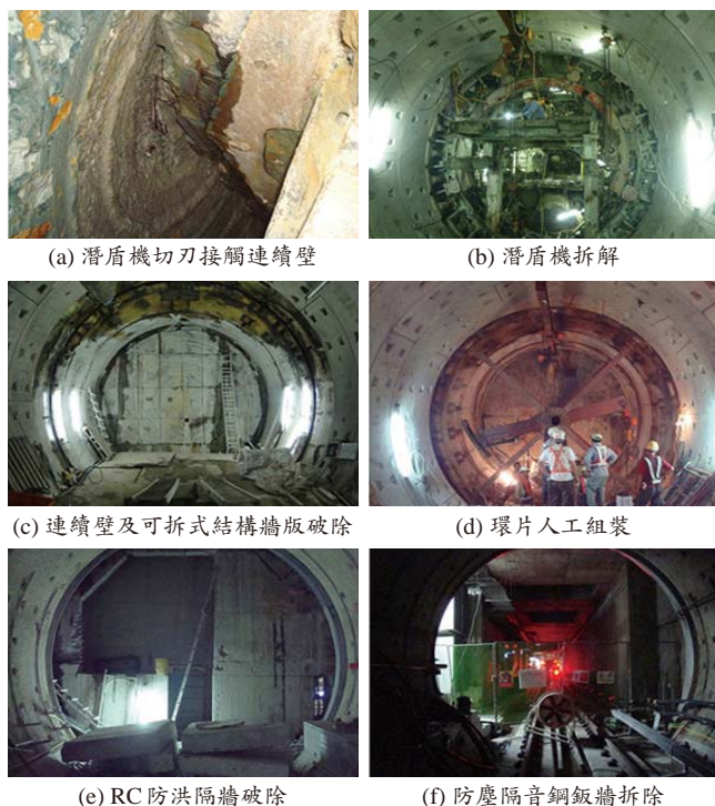
圖 16 鏡面破除施工照片
