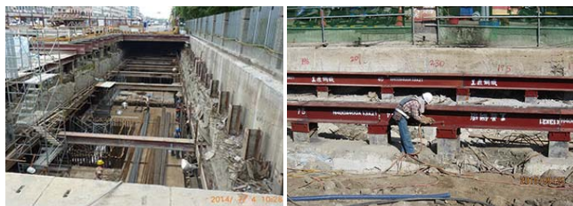
圖 4 連續壁預埋型鋼
