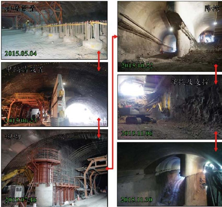
圖 12 消能池 1k+008.12 中間柱區域施工流程圖
