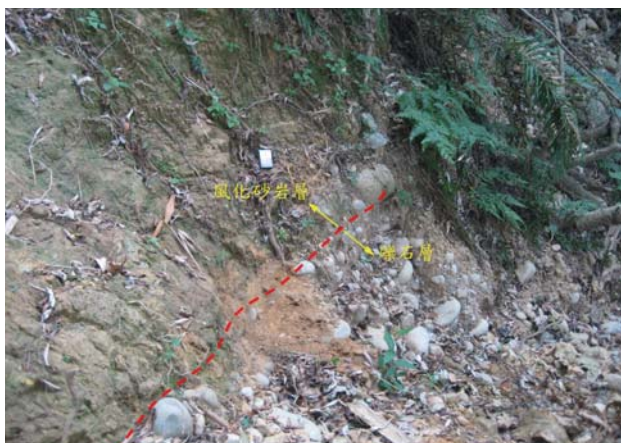
圖 2 新田靶場東側階地崖坡趾處之斷層露頭
