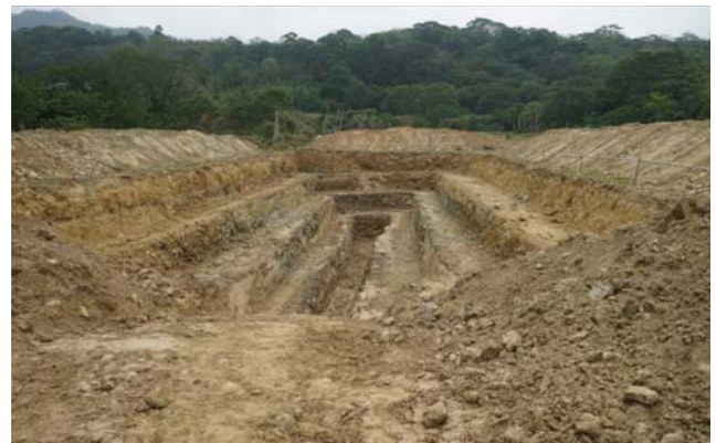
圖 5 槽溝開挖完成全景
