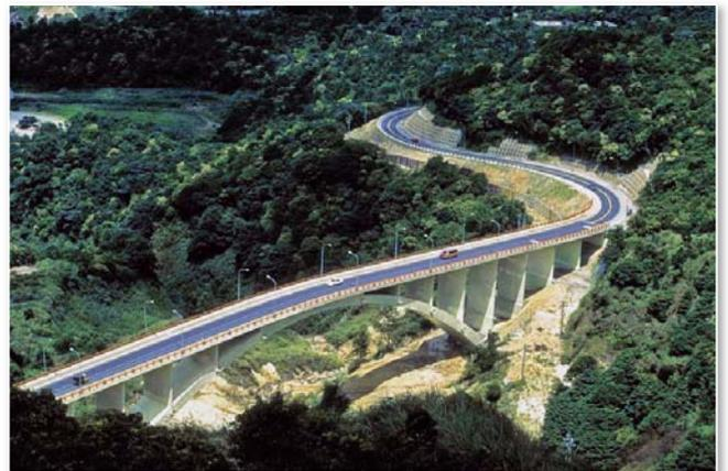
圖 20 馬槽橋之橋孔夠高夠寬不妨礙土石流通過（洪如江攝）
