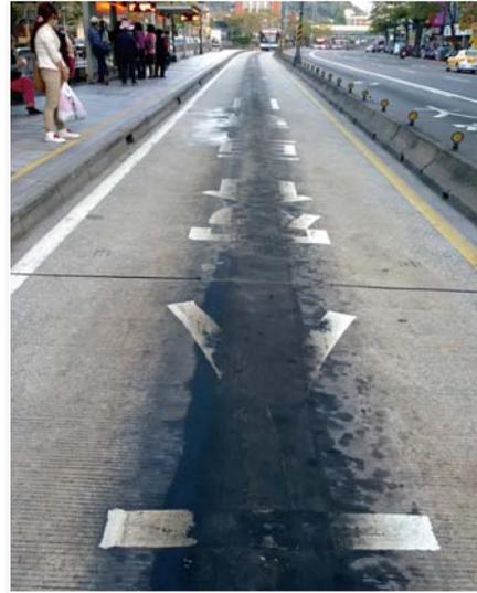
圖 23 燃燒柴油的大型汽車，在公車道混凝土路面留下顯而易見的證據（洪如江攝）
