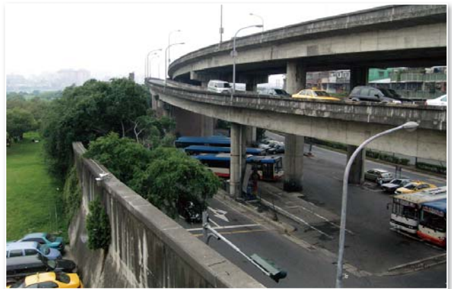
圖 41 台北市新店溪岸防洪牆及高架橋，阻擋市民親水活動，而且造成壓迫感，構成圍城效應（洪如江攝）
