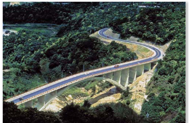
圖 20 馬槽橋之橋孔夠高夠寬不妨礙土石流通過（洪如江攝）
