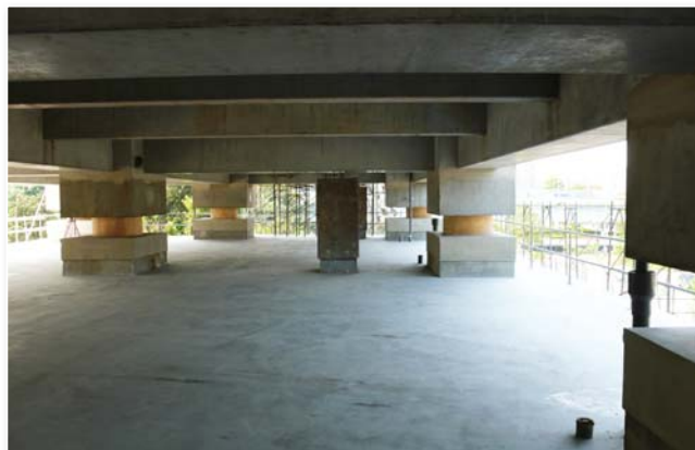
圖 57 高樓隔震層，裝設多個隔震墊，以隔絕地基上傳的地震波動（洪如江攝於台灣大學新研究大樓）
