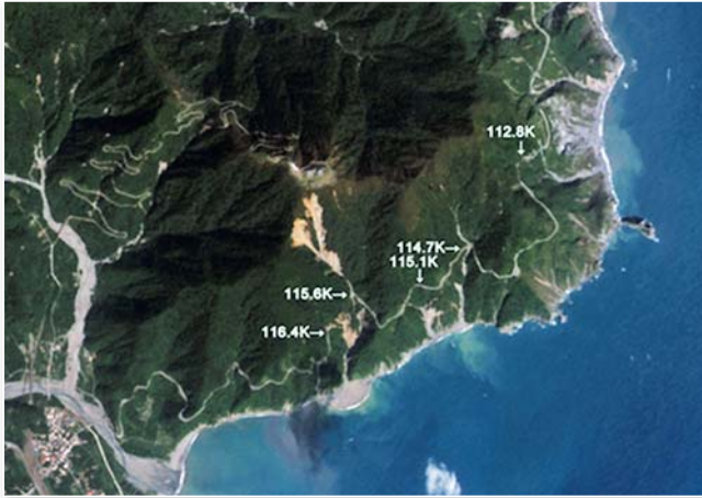
圖 32 梅姬颱風豪雨（民國 99 年 10 月 21 日），蘇花公路 112K~116K 多處發生嚴重災害，20 多人連同遊覽車墜落海域失蹤（資料來源：國家災害防救科技中心，太空中心）
