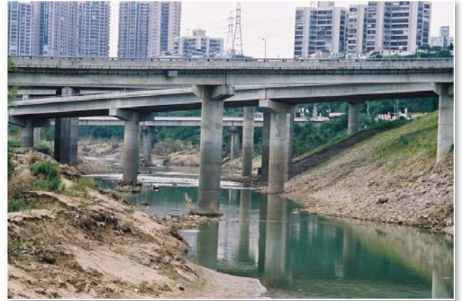
圖 19 汐止下游的基隆河狹窄河道塞入許多橋墩（洪如江攝）
