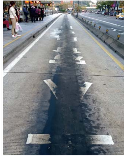
圖 23 燃燒柴油的大型汽車，在公車道混凝土路面留下顯而易見的証據（洪如江攝）
