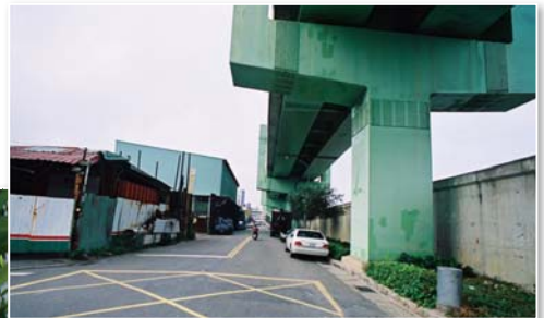
圖 42 台北市基隆河岸防洪牆及高架橋，阻擋市民親水活動，而且造成壓迫感，構成圍城效應（洪如江攝）
