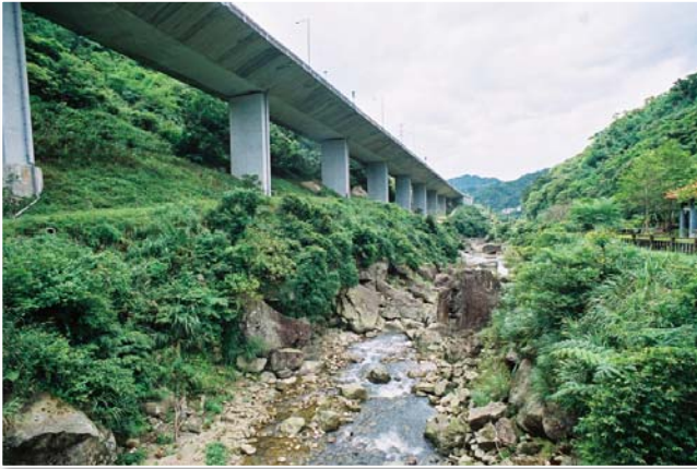
圖 18 北宜高速公路採用棧橋，避免大挖大填，與自然和諧（洪如江攝）
