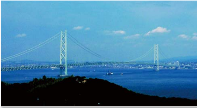
圖 22 日本明石大橋，主跨 1991 公尺，避免在水域中多建橋墩（洪如江攝）
