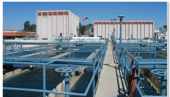
圖 19 美國桔郡工業污水處理廠局部（洪如江攝）
