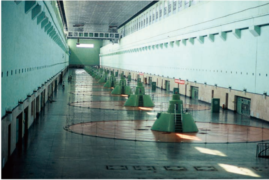
圖 23 一座大型水力發電廠房上層（洪如江攝於中國大陸長江某電廠）
