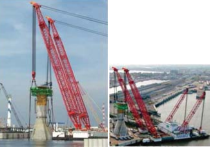
重力式之安裝工序是整地、吊裝基礎、裝塔架、裝風力機。
