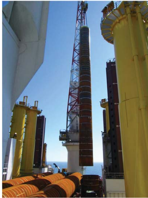
翻正吊樁作業(絞鏈車，自升船上，拉離吊車)
