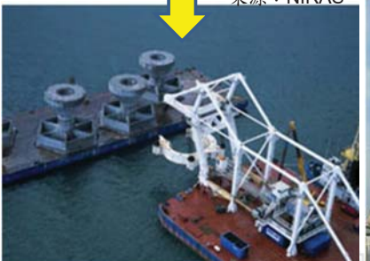
重力式之安裝工序是整地、吊裝基礎、裝塔架、裝風力機。
