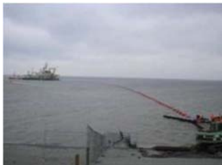
離岸風力機基礎安裝完成，緊接進行鋪纜作業，藉鋪纜船達成。 R&D Center 24
