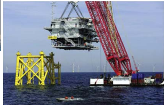
海運後以吊車船吊裝Jacket基礎及Topside。
