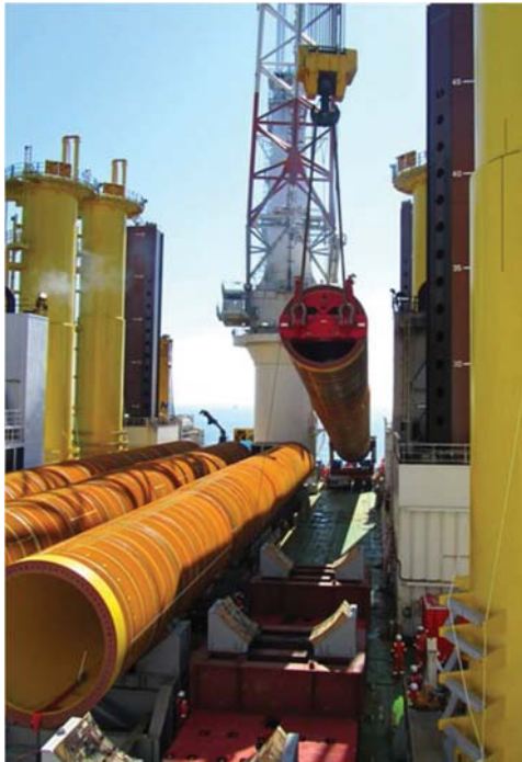
翻正吊樁作業(絞鏈車，自升船上，拉離吊車)
