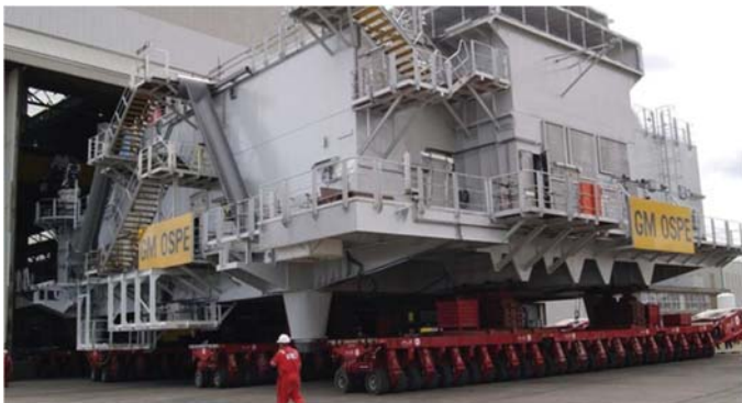
變電站上構大都以千噸級論，陸上很難找到匹配的重件吊車，通常採SPMT出廠及登船。
