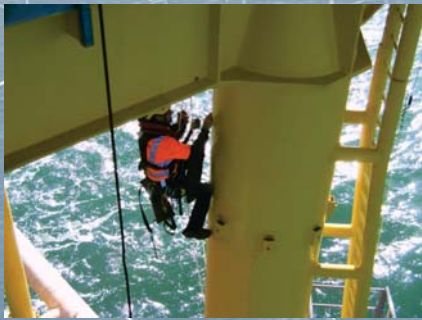
定期性塗裝檢測
