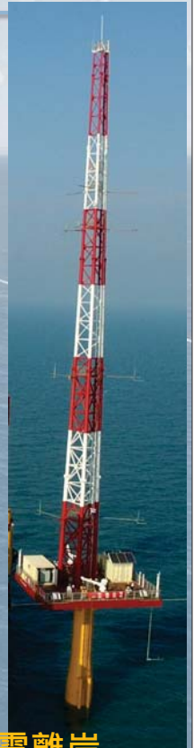
台電離岸測風塔 15
