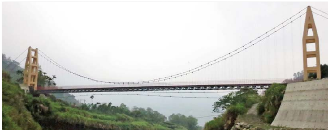
圖 11 完工後的如意吊橋充分發揮防、避災功能，成為山區小規模吊橋的最好示範。
