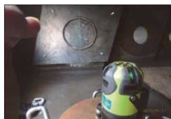
錨碇座與鋼導管中心點定位測量
