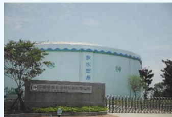
台中市精機園區四萬噸配水池工程
