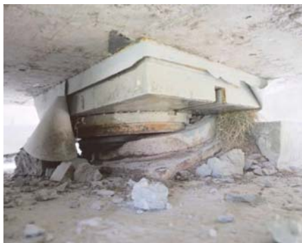
照片 1 RP7 單向活動支承嚴重破壞
