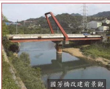
圖 1 工址位置圖及原橋照片
