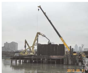
雙層圍堰打設
