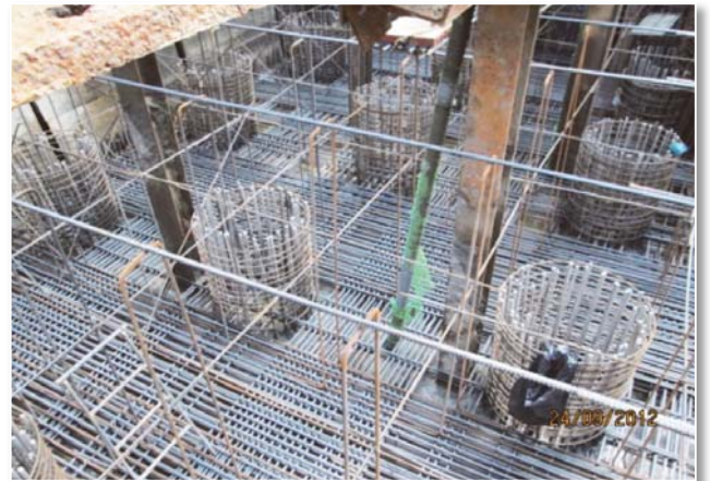
圖 19 基樁及基礎施作
