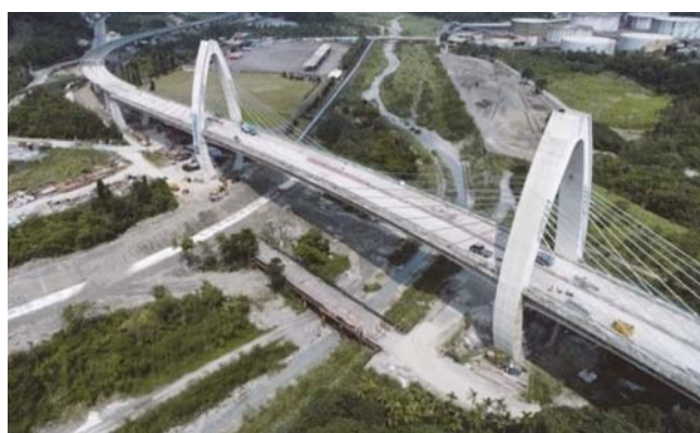
圖 43 全橋完成主體結構空照
