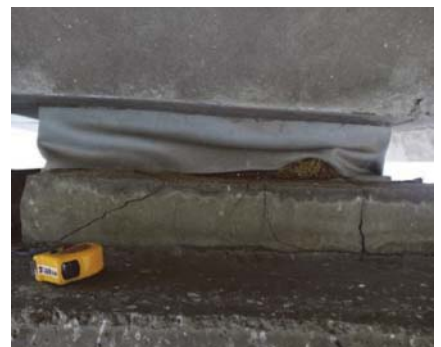
照片 6 LP7 支承墊破壞
