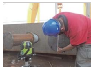
錨碇座與鋼導管中心點定位測量
