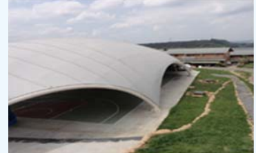
屏東縣禮納里公共建築第一、三期工程
