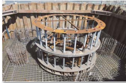
圖 26 橋塔基礎錨座
