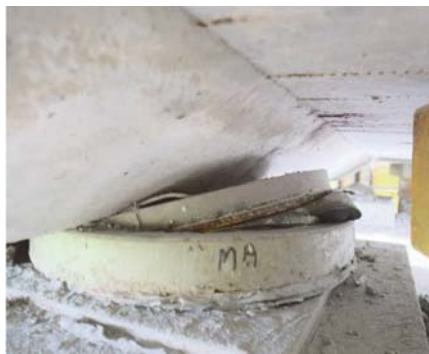
照片 2 RP7 雙向活動支承嚴重破壞
