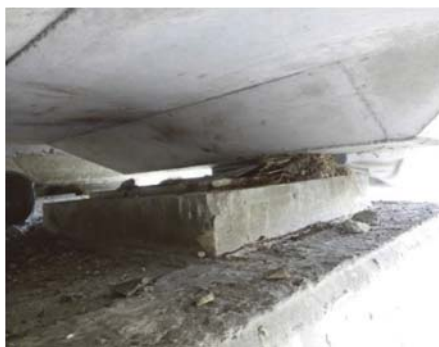
照片 4 RP7 雙向活動支承嚴重破壞
