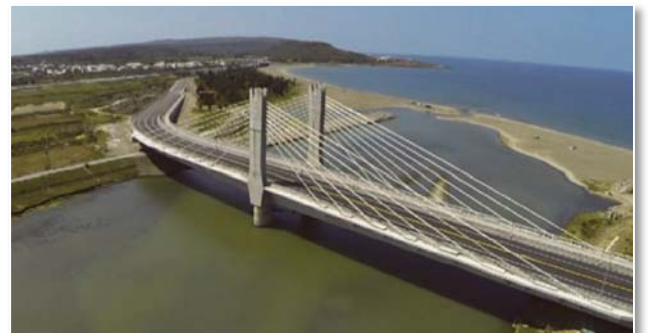
圖 31 福安大橋全景照片
