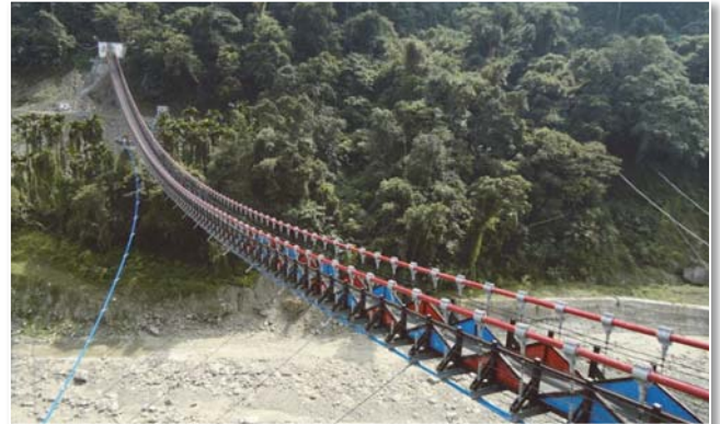
圖 13 吊橋刻意顯露結構原件呈現結構力學與美學結合的量體
