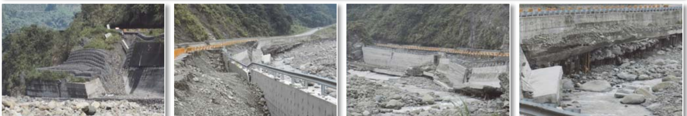
圖 18 149 甲線道路多次受災中斷受損嚴重
