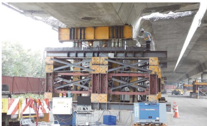
圖 13 現場設置之重型支撐架系統
