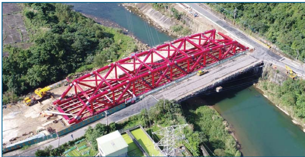
圖 16 國芳橋主構件吊裝完成照片
