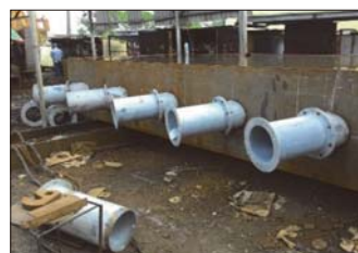
橋塔錨碇鋼箱鋼導管
