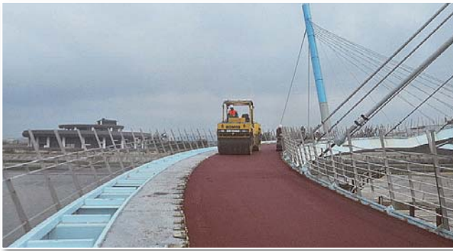
圖 34 橋面 AC 及欄杆施工
