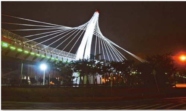
圖 6 鳳凰來儀陸橋地理位置位於台中國際機場之入口
