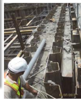
雙層圍堰填築不透水材料
