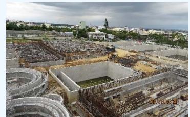
坪頂淨水場改善工程
