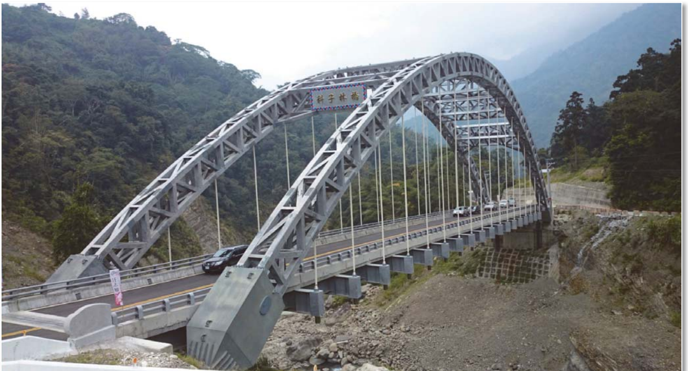
圖 6 新建的科子林橋 — 國內最長之鋼桁架拱肋鋼拱橋
