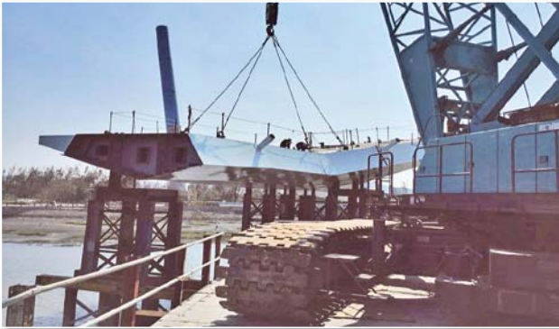
圖 28 鋼梁吊裝施工 (一)
