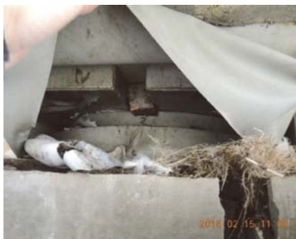
照片 5 LP7 支承墊破壞
