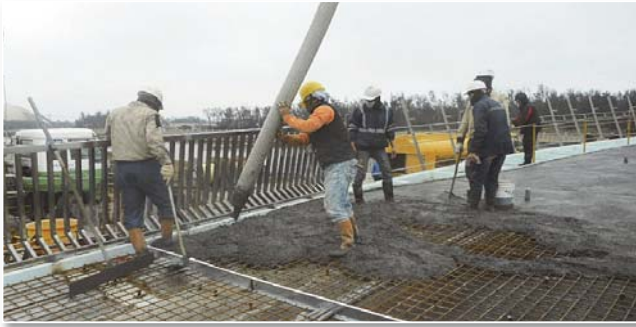
圖 33 橋面板施工
