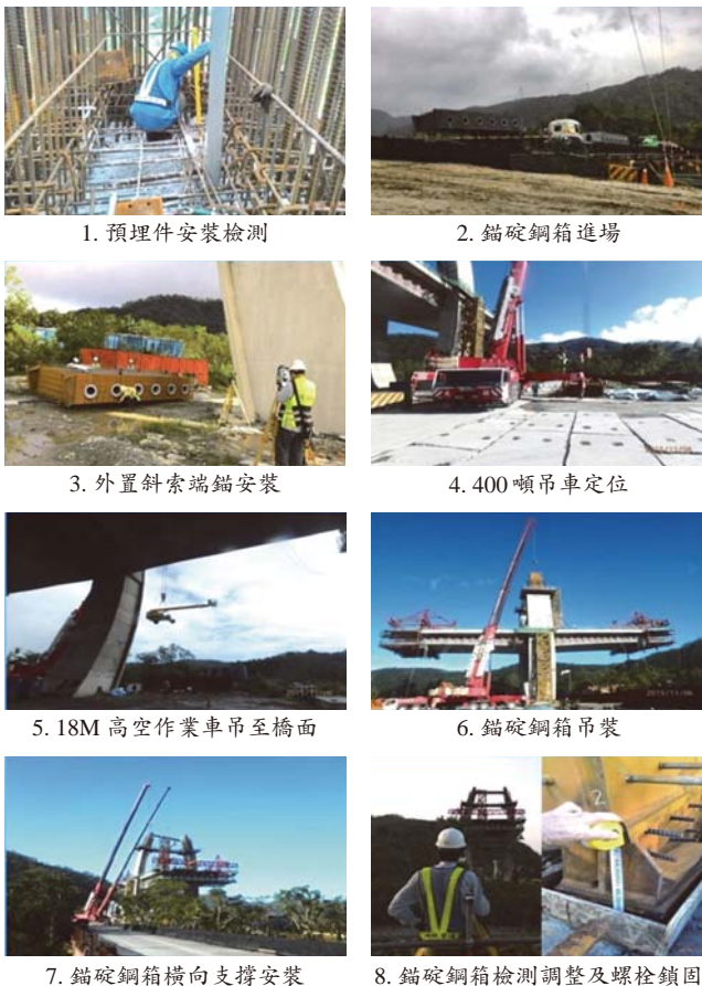
圖 40 錨碇鋼箱吊裝施工流程
