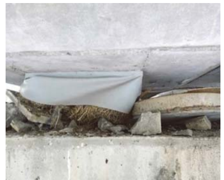
照片 3 RP7 單向活動支承嚴重破壞
