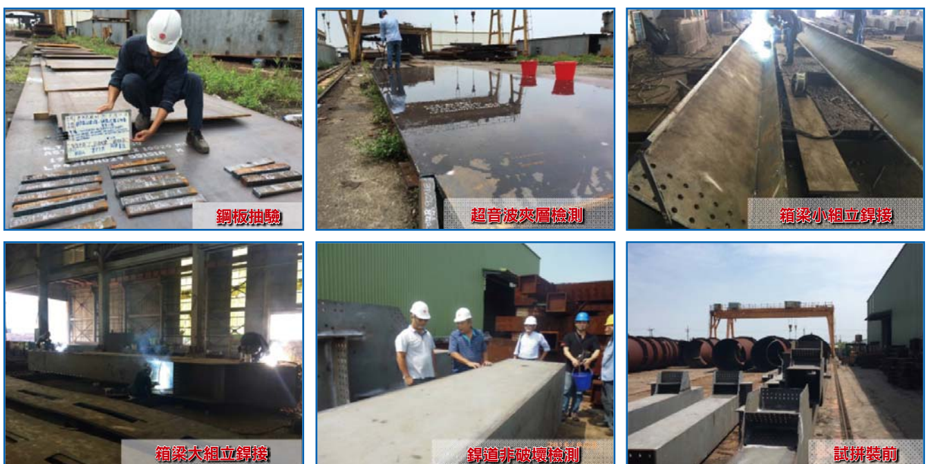
圖 14 鋼構施工查驗情形
