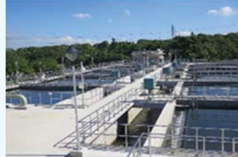
豐原場新設初沉池工程_土建部份
