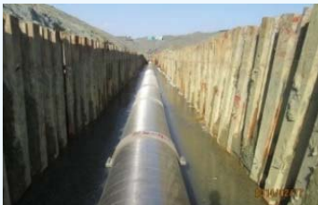
高屏堰上游傍河取用伏流水工程
