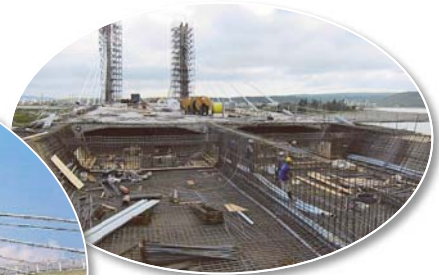
圖 24 邊跨場鑄段施工
