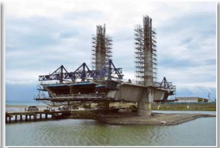
圖 22 橋塔施築及平衡懸臂工法施作
