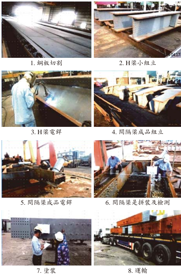
圖 34 鋼製間隔梁產製加工流程
