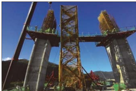
圖 26 橋塔錨碇鋼箱吊裝施工
