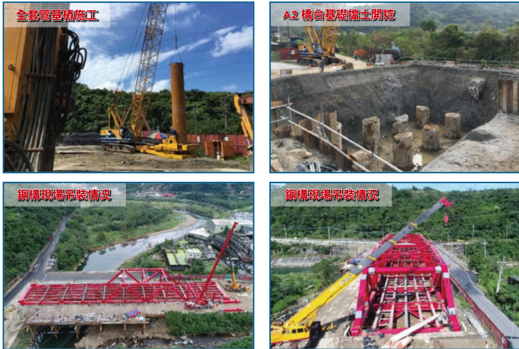
圖 15 國芳橋現場施工照片
