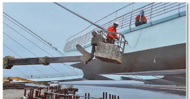
圖 31 鋅鋁熔射補漆
