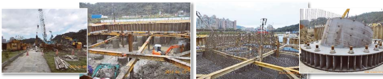
圖 18 星光橋橋塔基礎施工照片
