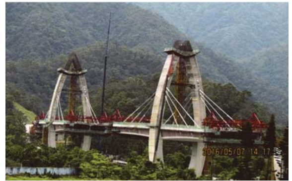
圖 41 平衡懸臂施工
