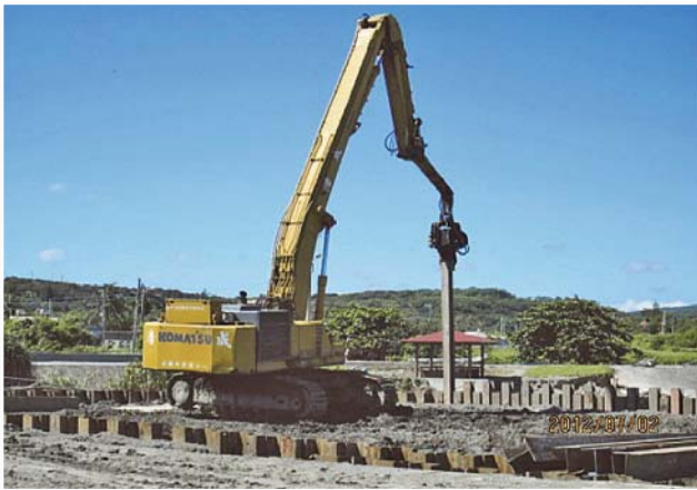
圖 18 圍堰及基礎開挖
