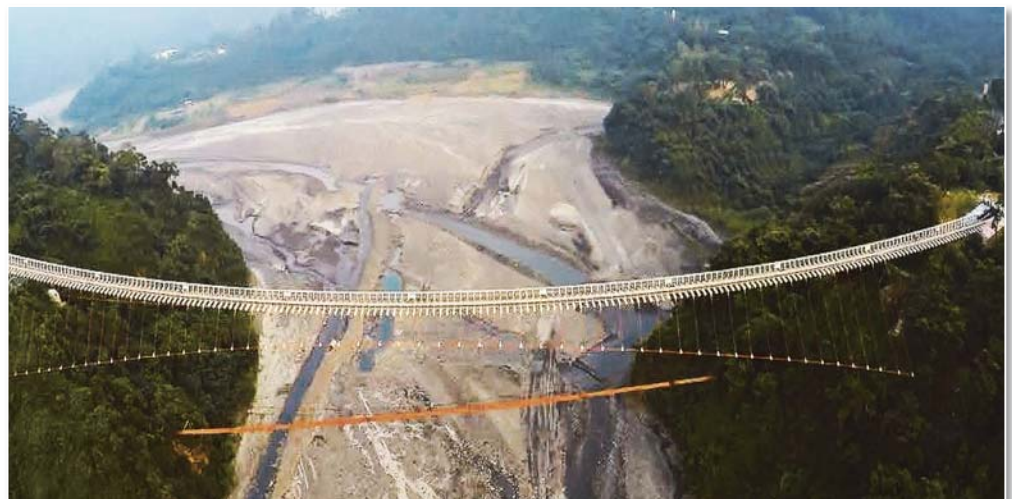
圖 18 吊橋每根抗風支索的斜拉角度均經過精心規劃設計讓橋面更加穩定（下方為舊三地門吊橋）
