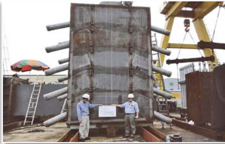
圖 21 橋塔鋼殼於鋼構廠假組立
