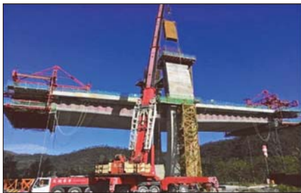
橋塔錨碇鋼箱吊放 施工中
