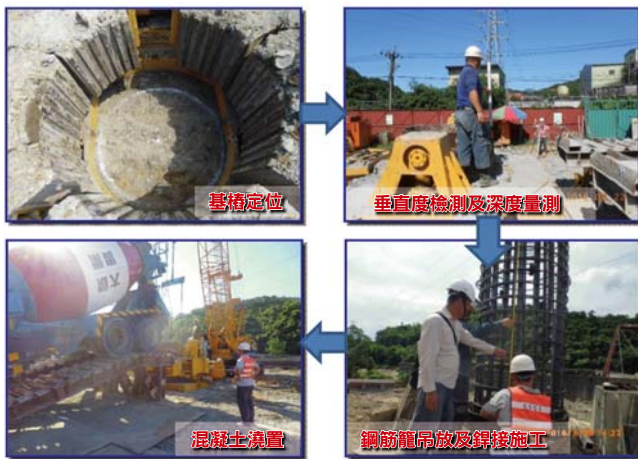
圖 13 基樁施工查驗情形
