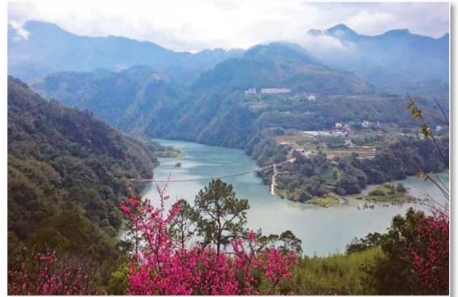
圖 21 新溪口吊橋長度 303 公尺為目前國內跨徑最長的人行吊床式吊橋
