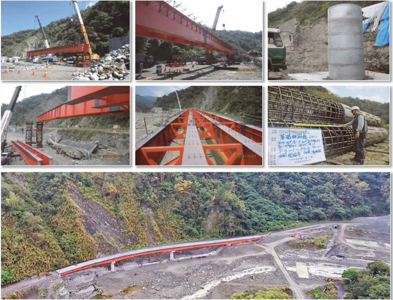
圖 22 施工中及完工後之沙沙歐橋
