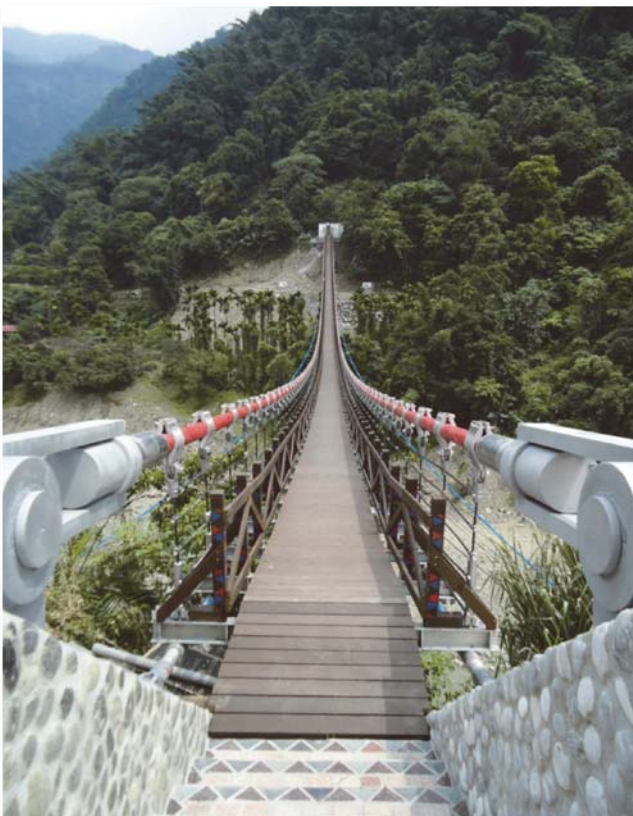
圖 12 福美吊橋長度 175 公尺是當時國內跨徑最長的人行吊床式吊橋
