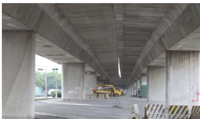
圖 3 大梁向外位移現況照
