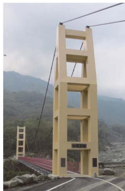
圖 8 如意吊橋鋼橋塔
