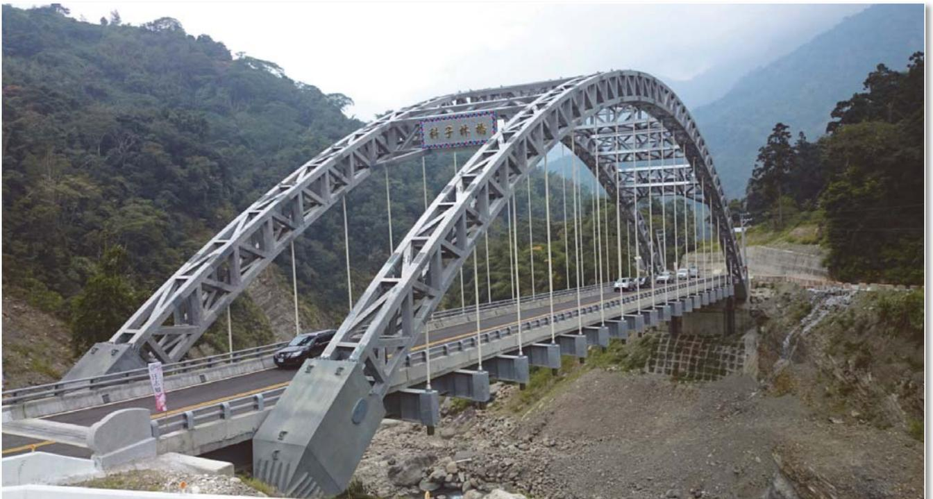
圖 6 新建的科子林橋 — 國內最長之鋼桁架拱肋鋼拱橋
