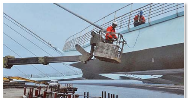
圖 31 鋅鋁熔射補漆
