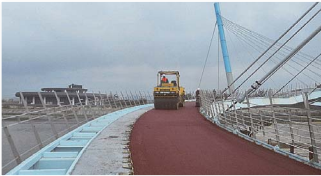
圖 34 橋面 AC 及欄杆施工
