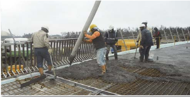
圖 33 橋面板施工
