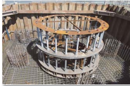
圖 26 橋塔基礎錨座
