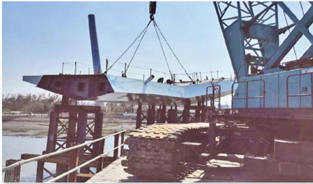
圖 28 鋼梁吊裝施工 (一)
