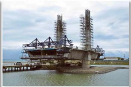
圖 22 橋塔施築及平衡懸臂工法施作
