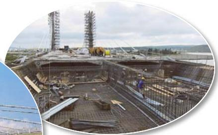
圖 24 邊跨場鑄段施工
