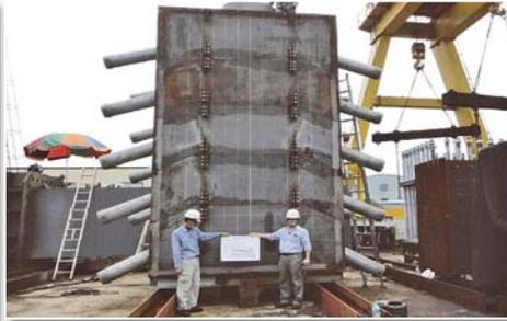
圖 21 橋塔鋼殼於鋼構廠假組立
