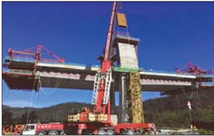
橋塔錨碇鋼箱吊放
