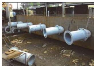
橋塔錨碇鋼箱鋼導管
