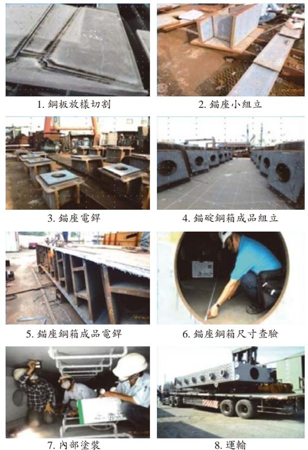
圖 36 錨碇鋼箱產製流程
