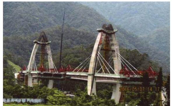
圖 41 平衡懸臂施工
