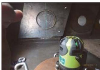
錨碇座與鋼導管中心點定位測量
