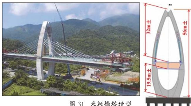
圖 31 米粒橋塔造型
