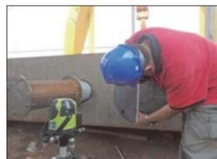
圖 25 橋塔錨碇鋼箱施工精度控制 [7, 榮工工程公司]
