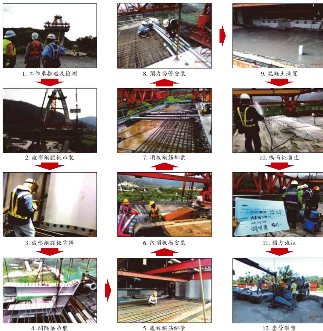
圖 42 平衡懸臂施工主要流程
