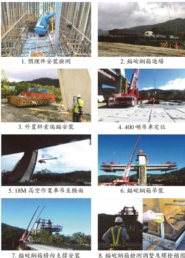
圖 40 錨碇鋼箱吊裝施工流程
