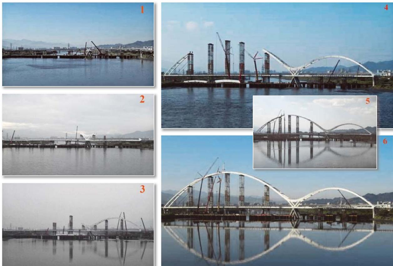
圖 16 新月橋上部結構施工照片
