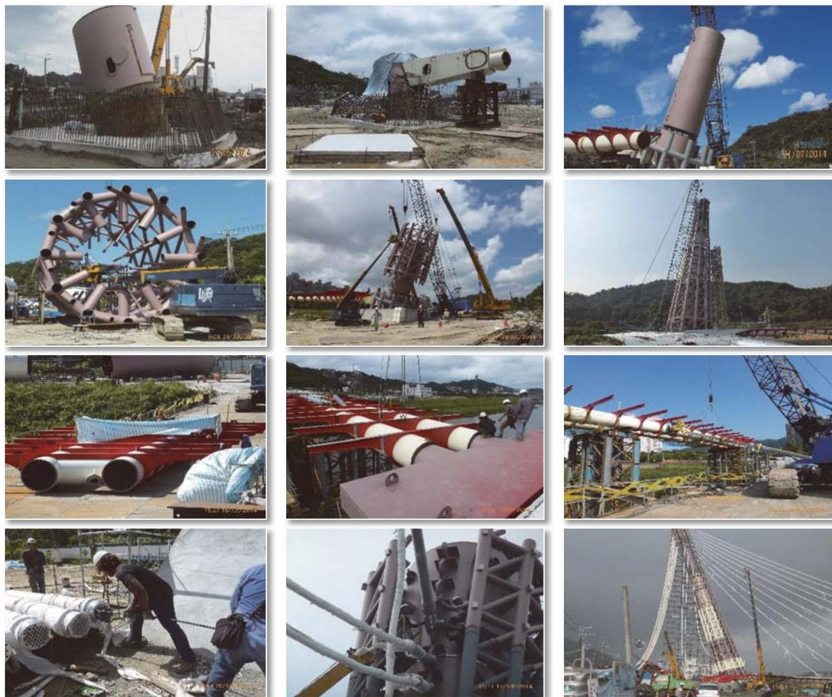
圖 19 星光橋橋塔、橋面鋼管梁及吊索施工照片
