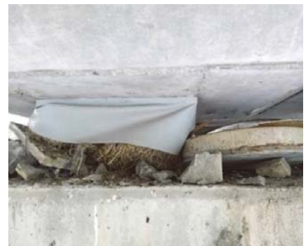
照片 3 RP7 單向活動支承嚴重破壞
