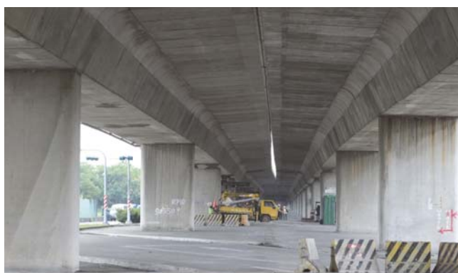
圖 3 大梁向外位移現況照
