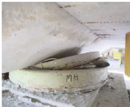
照片 2 RP7 雙向活動支承嚴重破壞
