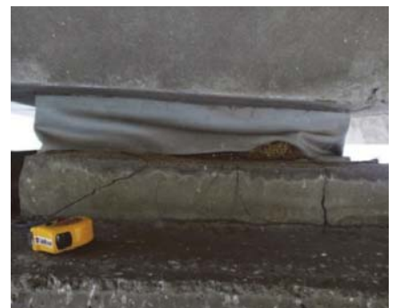
照片 6 LP7 支承墊破壞
