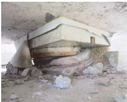
照片 1 RP7 單向活動支承嚴重破壞
