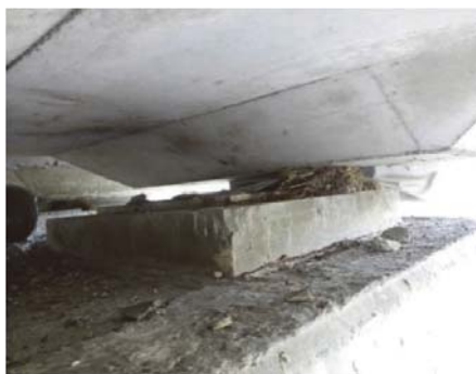
照片 4 RP7 雙向活動支承嚴重破壞
