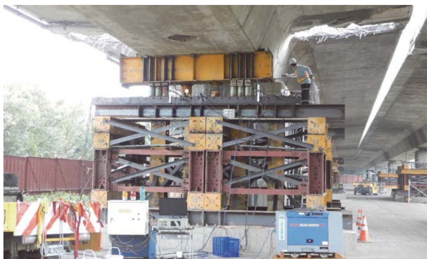
圖 13 現場設置之重型支撐架系統
