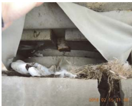
照片 5 LP7 支承墊破壞
