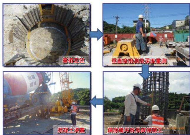
圖 13 基樁施工查驗情形
