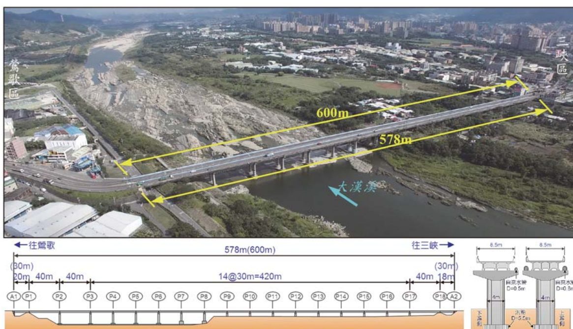
圖 6 三鶯大橋原橋空拍與立面圖、斷面圖
