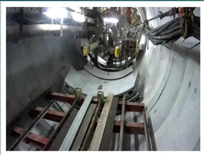
4号機 掘進・組立
