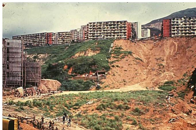
寶珊道塌坡(1972) – 67人死亡
