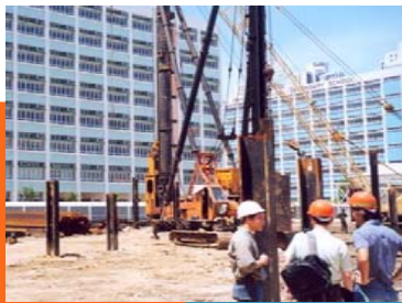
監察打樁工程
